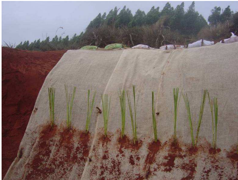
Figura 1. Implantação de mudas de capim Vetiver em talude de ravina para teste preliminar de sobrevivência, realizado em junho de 2014. Fonte: C.L. Vieira, 06/2014.
