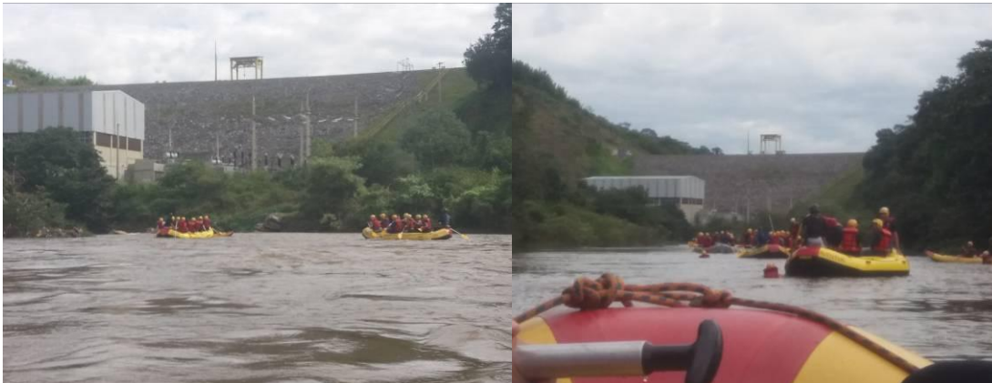
Figura 6: Vista da barragem da PCH de Santa Fé do bote.
