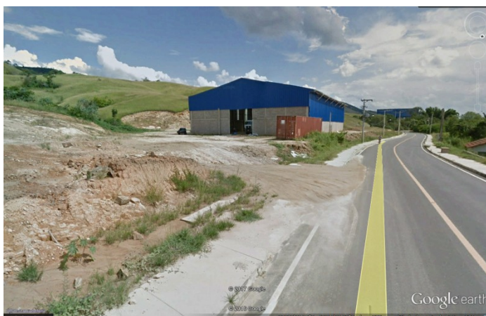
Figura 5: Evidências de processos erosivos provenientes do corte de terreno para instalação de indústrias, gerando sedimentação na pista e entupimento das drenagens na Estrada da Barrinha que liga os municípios de Três Rios e Paraíba do Sul, RJ.
