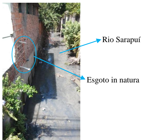
Figura 7: Despejo de esgoto in natura no Rio Sarapuí, bairro Frigorífico.
