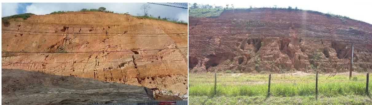
Figura 3: Erosões laminares e lineares em corte de encosta no município de Viçosa/MG. Foto: AMARAL, C.M., 2015.
